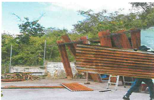
Foto1: MODULO 1 TECHADO DE METAL POR ESTRUCTURA DE MADERA
