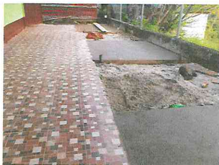
Foto 3: MODULO SUSTIRUCION DE TIERRA POR TORTA DE CEMENTO
