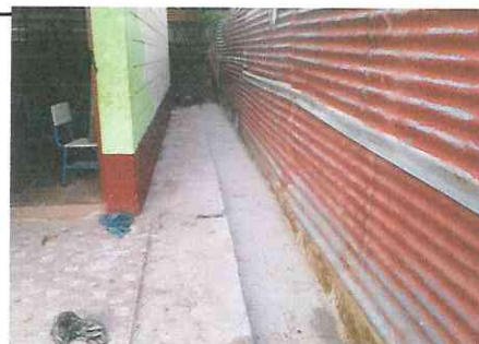
Foto 4: MODULO 2 SUSTITUCION DE TIERRA POR TORTA DE CEMENTO
